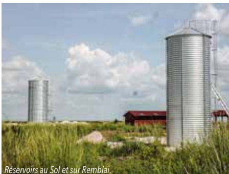
Réservoirs au Sol et sur Remblai.
